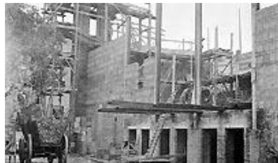
Die Kirche als Baustelle
