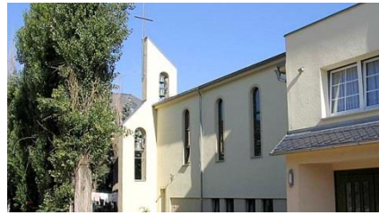
St. Antonius Chemnitz Erfenschlager Straße 27 09125 Chemnitz
