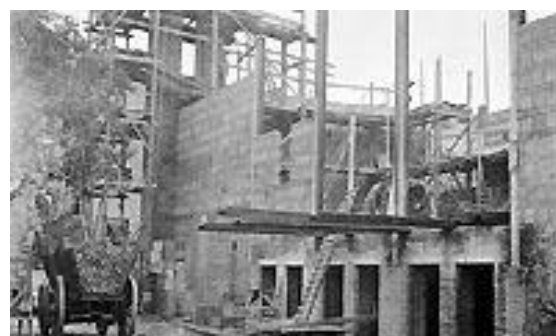
Die Kirche als Baustelle
